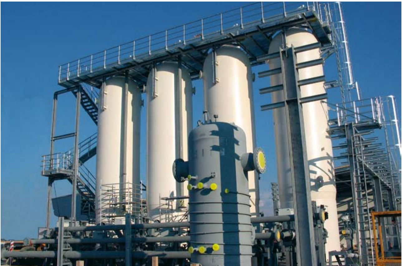
Montage einer Erdgasaufbereitungs-Anlage für einen Untergrundspeicher Assembly of a natural gas treatment unit used for an underground storage
