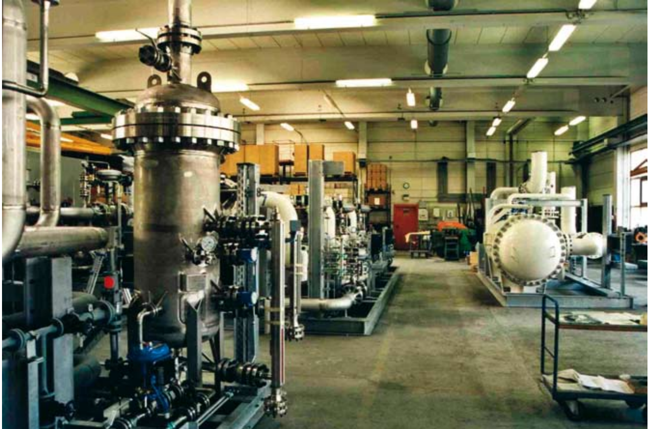
Vormontage von Skids für eine Erdöl-Begleitgas-Trocknung Preassembly of skids for a drying unit for petroleum gas
